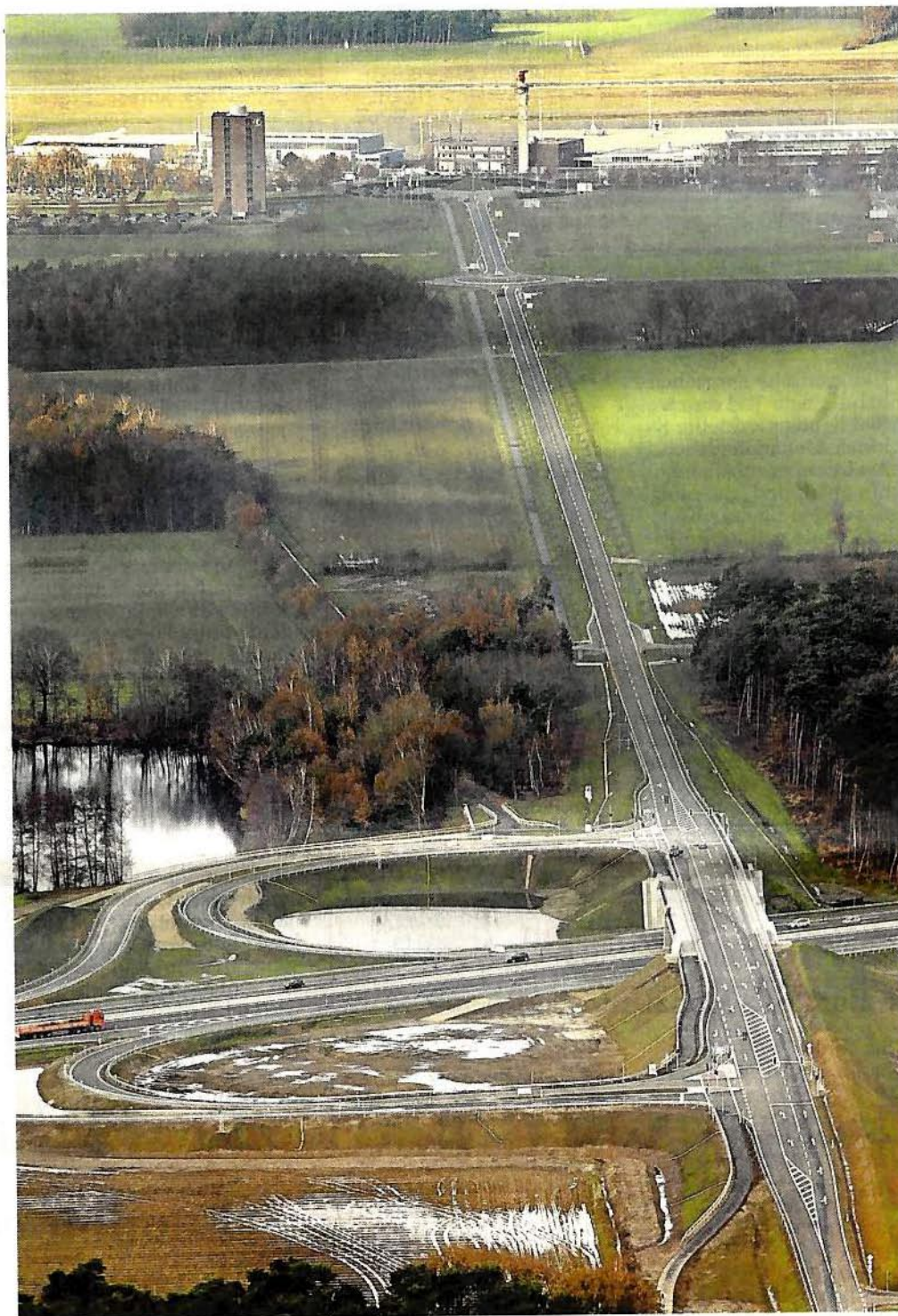
Von der A 1 direkt zum Flughafen Münster/Osnabrück: Der neue Zubringer ist 2,5 Kilometer lang. Heute wird er freigegeben.
